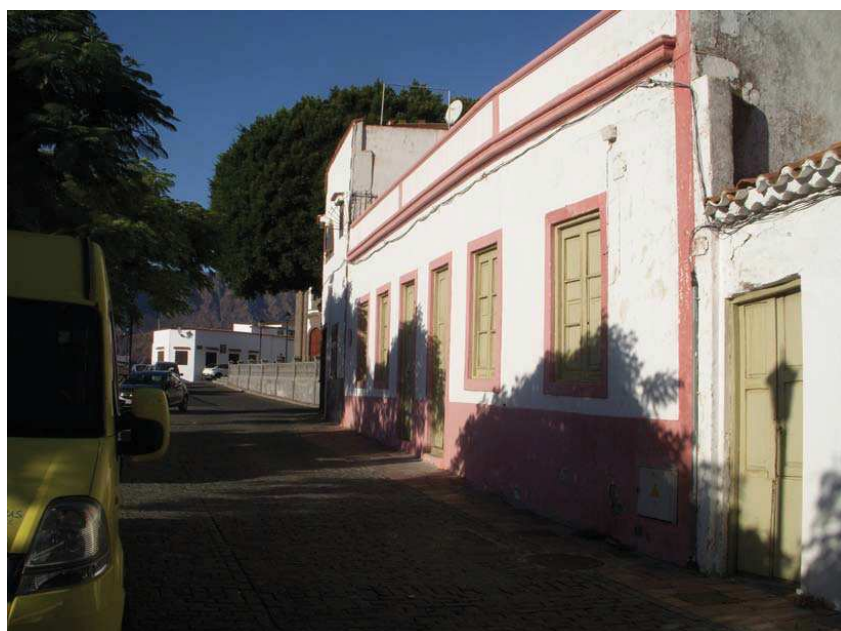
Imágenes de la calle Senador Castillo Olivares donde se puede apreciar la plaza donde se sitúa la Iglesia de Santa Lucía, así como la edificación situada en la parcela objeto de la Ordenanza.
